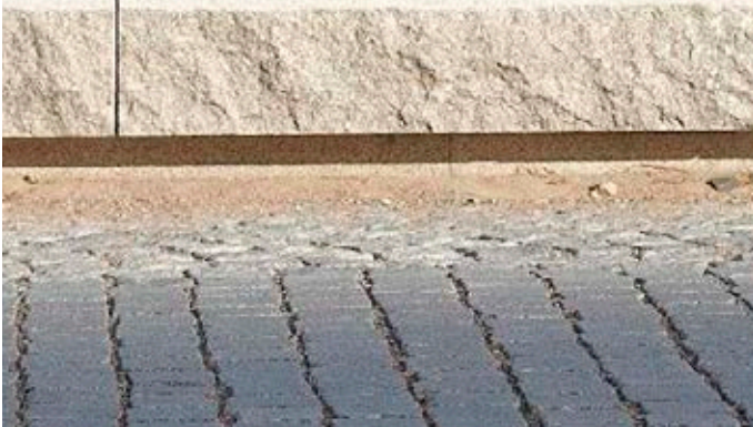
Grå Bjärlovsgrenit, krysshamrad översida, råkilade långsidor Objekt: Dockan, Malmö
