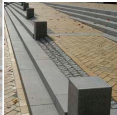
Fyrkantig stolpe av Grå Bjärlövsgranit, flammad
