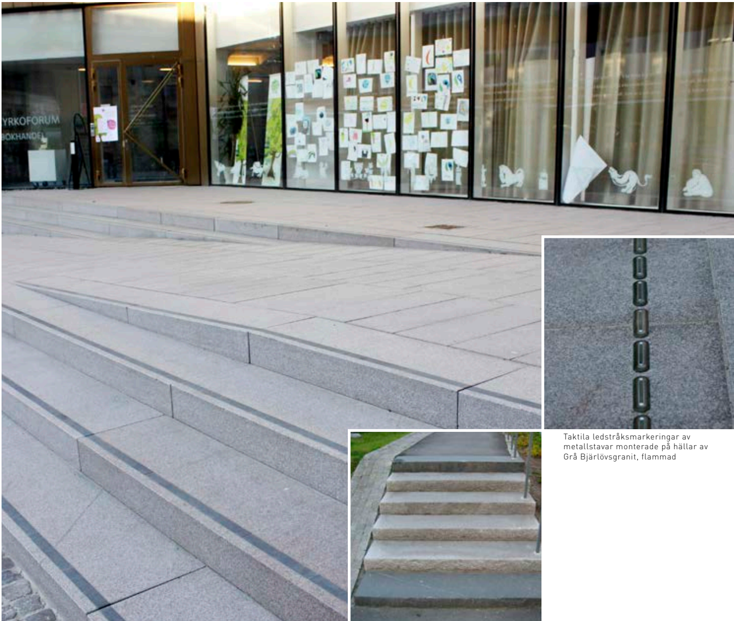
Ramp och trappa av Grå Bjärlövsgranit, flammad. Infällda kontrastmarkeringar av Svart Diabas, blåstrad. Objekt: Domkyrkoforum, Lund
