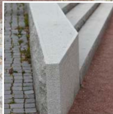
Blockstensmur av Grå Bjärlövsgrenit, krysshamrad med en råkilad sida.
