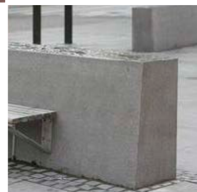
Blockstensmur av Grå Bjärlövsgrenit, flammad
