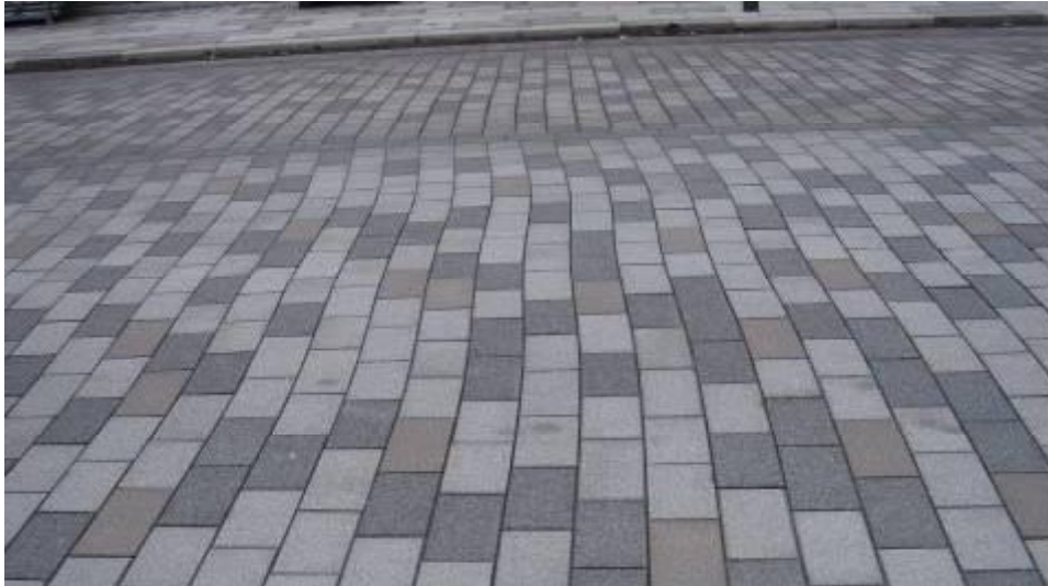
Figur 5. Plattor, med sågad undersida lagda i sand, som glidit på underlaget i trafikriktningen. Fogarna är fortfarande intakta och håller avståndet mellan plattorna. Mönstret har brutits. Plattorna är inspända från sidorna med kantsten, men är fria i körytans längdriktning. OBS! plattorna på detta foto har ett mycket speciellt format, är små <0,05m^2 och kan närmast liknas vid på alla sidor sågad storgatsten och faller därför inte inom projektet för hällar som ju ska vara <0,1 m^2 . Bilden visar dock på ett bra sätt principen för glidning. Om den genomgående fogen gått i körriktningen skulle glidningen inte ha märkts, eftersom plattorna i den riktningen är i fallande format och fogarna då inte skulle vara genomgående utan förskjutna och på slumpmässiga avstånd. Nu finns det dock tunga, konstruktionsmässiga skäl att inte lägga genomgående fogar längs körriktningen. (Foto: Kurt Johansson).
