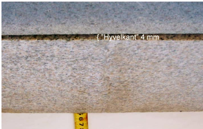
Figur 8. Undersidan på bällarna med individuell tjockleksskillnad på 4 mm vilket ger en "hyvelkant" om 4 mm vilket borde ge en god friktionseffekt för hela beläggningspaketet. Ska-lan framgår av måttbandet som är graderat i centimeter. (Foto: Kurt Jobansson).
