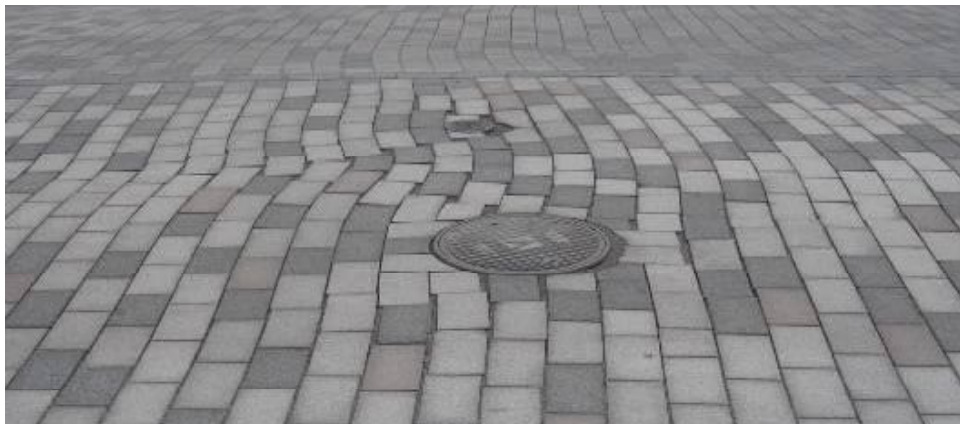
Figur 6. Glidningen har stoppats vid brunnar. Mönstret har brutits. OBS! att plattorna på detta foto är små <0,05m^2 och ligger inte inom projektet hällar. Bilden visar hur glidningen stoppas upp av punktformat "mothåll". (Foto: Kurt Johansson).
