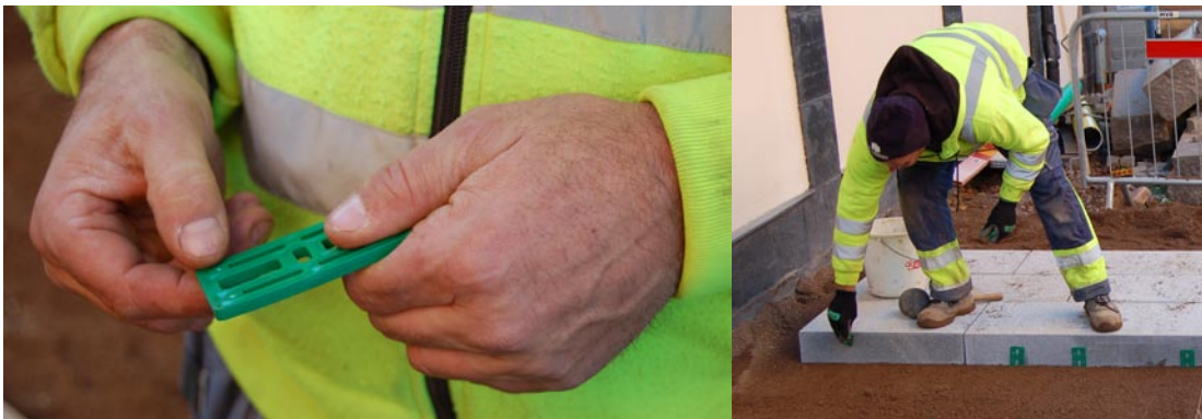
Figur 13. En distans av plast används för att skapa det rätta avståndet mellan hållarna. (Foto: Sabina Jallow).
