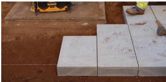
Figur 4. Trenden för sågade plattor är att tjockleksskillnaden blir allt mindre för att läggningen skall underlättas. (Foto: Sabina Jallow).
